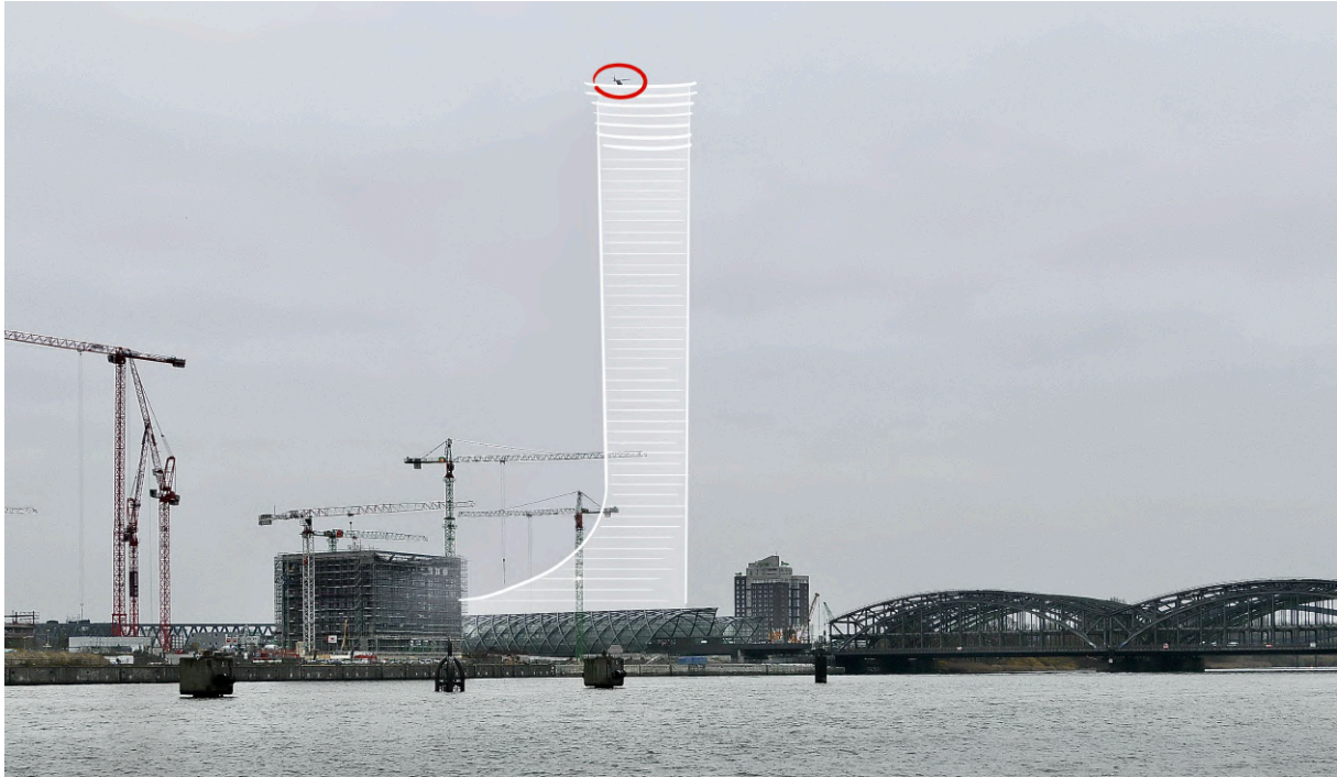
Geplanter Elbtower vom Kleinen Grasbrook aus gesehen mit Hubschrauber auf 245 m [Foto: privat]
